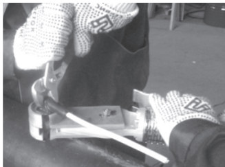
Рис. 3 Изделие «СКВ» разогревается в «насадке сварочной»
