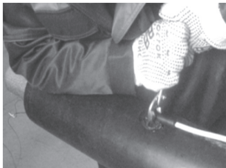
Рис. 4 Изделие «СКВ» вваривается в оболочку трубы
